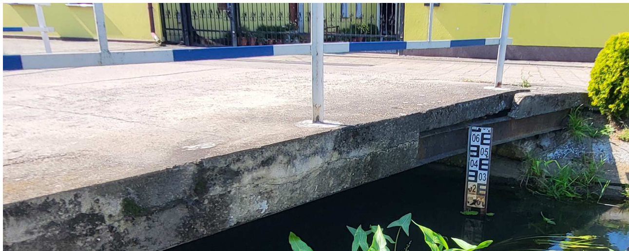
Zdj. 5 Widok płyty z boku od górnej wody, widoczne pęknięcie płyty na belce skośnej
