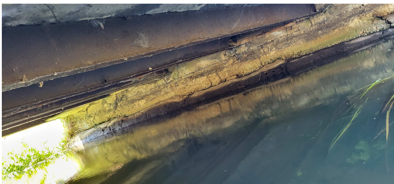
Zdj. 6 Widok płyty mostu od spodu, widoczne skorodowane belki stalowe
