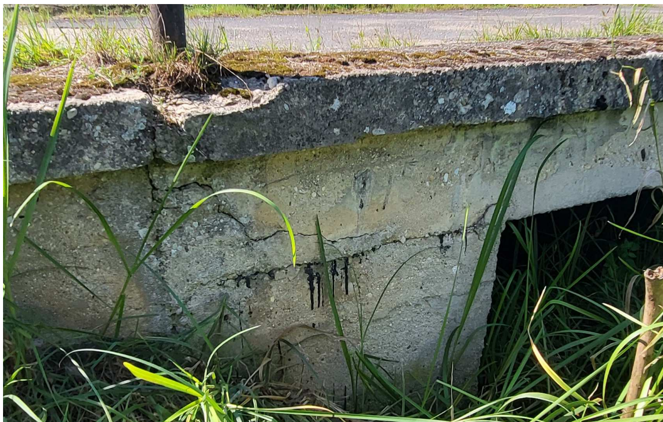
Zdj. 12 widok połączenia płyty mostu z przyczółkiem. Widoczne zacieki bitumiczne, beton płyty był wylewany na zaizolowany przyczółek.
