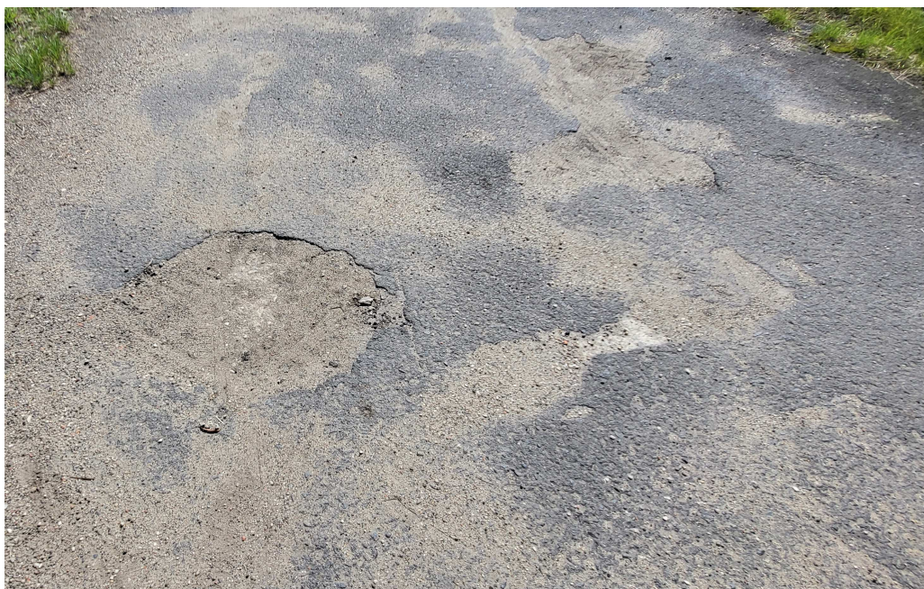
Zdj. 3 widoczne ubytki w nawierzchni, duże nierówności oraz porost roślinności przy karpach
