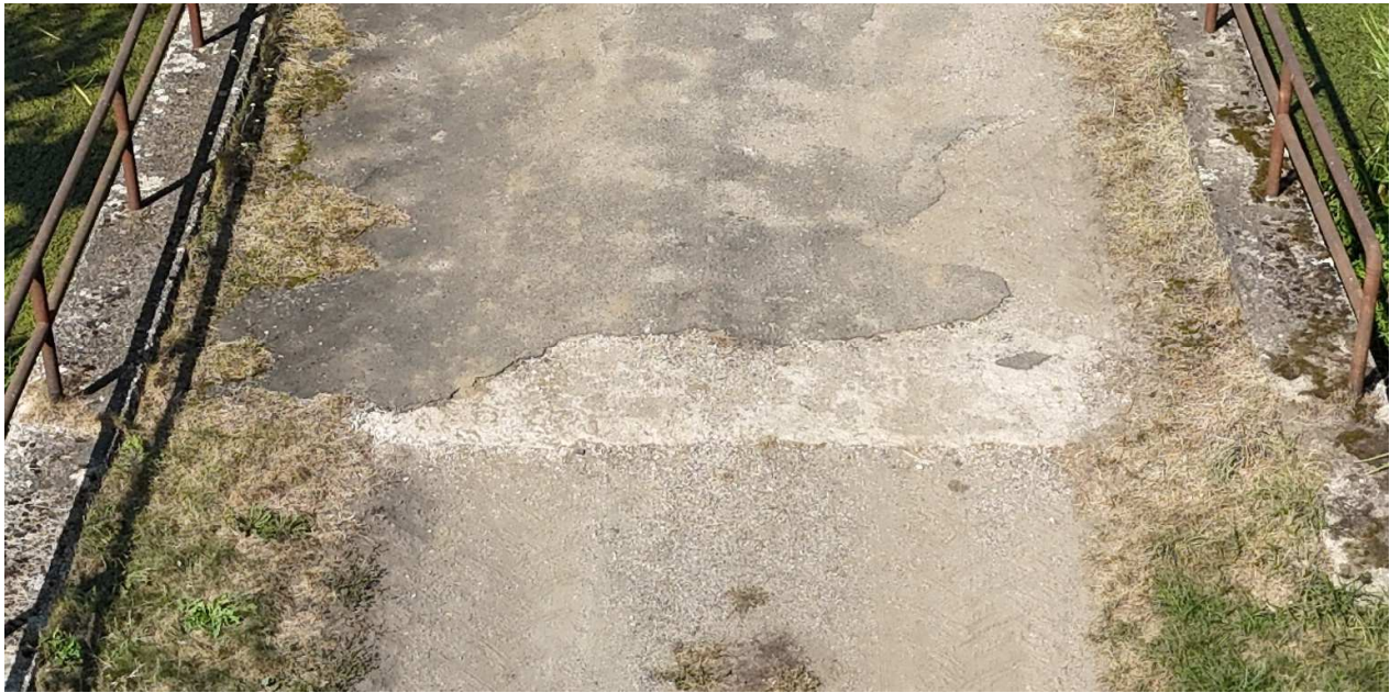
Zdj. 7 Połączenie obiektu z nasypem drogi. Brak urządzeń dylatacyjnych
