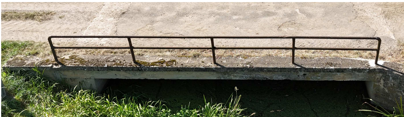
Zdj. 4 Zniszczenie kapy skrajnej od górnej wody. Duże ubytki betonu, postępująca karbonatyzacja betonu, miejscami lokalne naprawy zaprawami PCC
