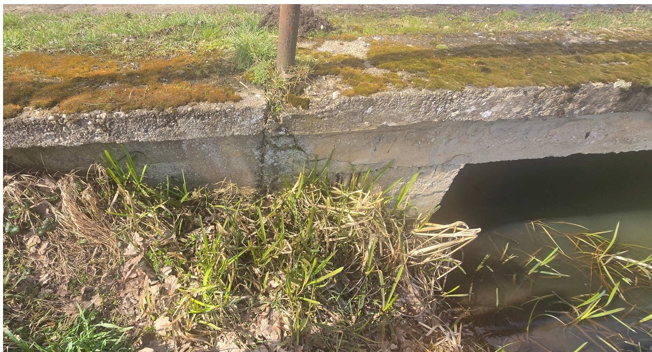
Zdj. 6 połączenie skrzydła z ustrojem nośnym, brak dylatacji. Beton skrzydeł został dolany bezpośrednio do przyczółka i płyty
