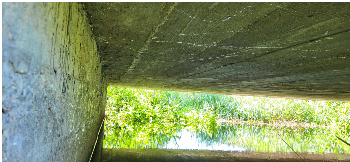
Zdj. 11 Widok na połączenie płyty z przyczółkiem.
