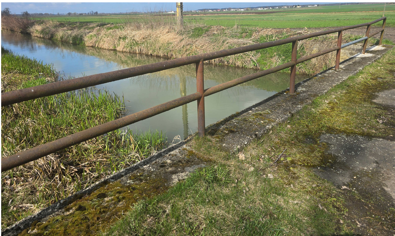
Zdj. 5 Zniszczenie kapy skrajnej od dolnej wody. Duże ubytki betonu, postępująca karbonatyzacja betonu, miejscami lokalne naprawy zaprawami PCC, występuje na kapach roślinność
