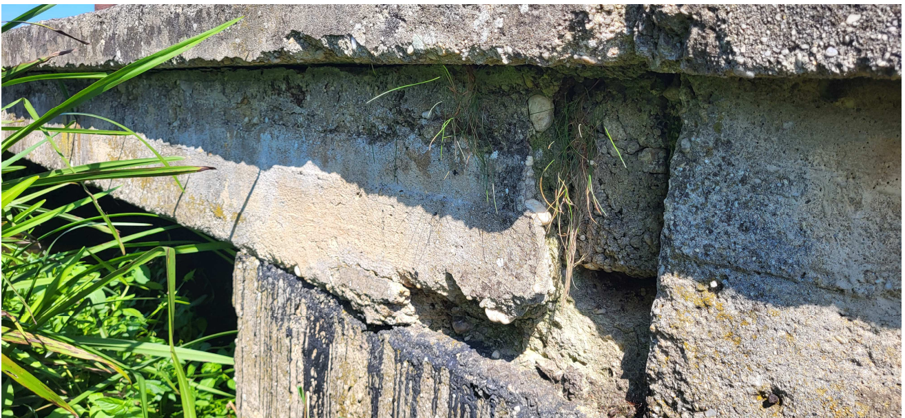
Zdj. 8 Widok płyty mostu nad przyczółkiem od strony ulicy Wodnej. Widoczna jest część dolna nośna grubości 23cm, wyżej beton wyrównawczy gr. 10cm i kapa chodnikowa gr. 13cm. Beton żwirowy z ubytkami.
