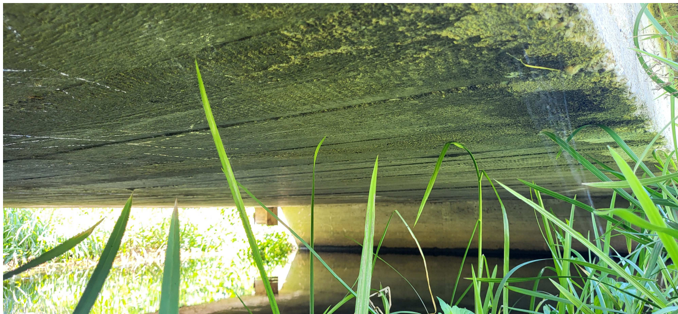
Zdj. 9 Widok płyty mostu od spodu, w miejscach zarysowań białe wytrącenia gipsu
